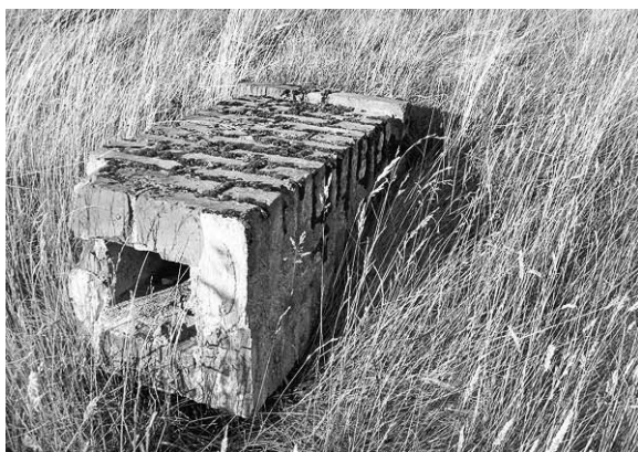
Fig.33. Vestigio de una chimenea construida con ladrillos Marcou (Fotografía del autor, 2013).
