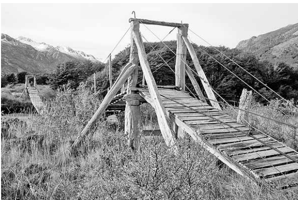
Fig.41. Puente sobre el río Fontaine construido por Alejandro Concha con la colaboración de Reinaldo Catalán en 1994 (Fotografía del autor, enero 2011).
