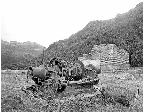
Fig.23. Steam Winch de la firma Clarke, Chapman Company, Gateshead, England (Fotografía del autor, caleta María, 2013).
