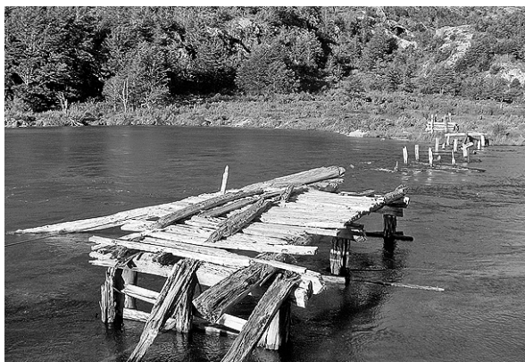
Fig.28. Vestigio de puente sobre el río Azopardo (Fotografía del autor, 2013).
