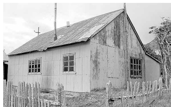
Fig.37. Casa administración del aserradero “Caleta María”, construida en la década de 1950 (Fotografía del autor, 2013).
