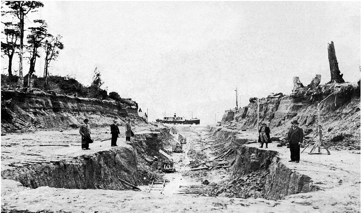
Fig.2 Boca del canal hacia el norte, que muestra el estado de los trabajos hacia 1941.
