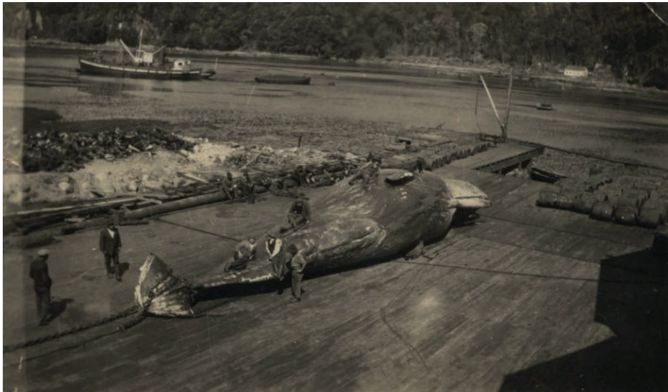
Fig.9. Una vista de la plataforma de descuartizamiento y rampa de la planta ballenera de Guafo [Foto gentileza de Fernando Oettinger].
