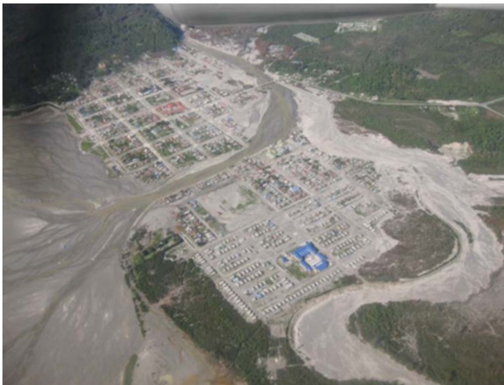
Fig. 1. Vista Aérea de Chaitén post erupción del Volcán Chaitén y con el Río Blanco dividiendo el pueblo en dos partes. Fuente: Consultoría PUC/UACH. 2010.
