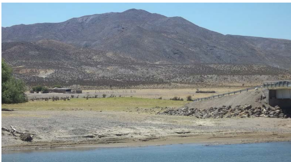
Fig. 4. Puente sobre el río Chubut en el paraje Gorro Frigio; como en otros casos con efectos trascendentes en la dinámica espacial. Fuente: fotografía del autor, enero de 2015.
